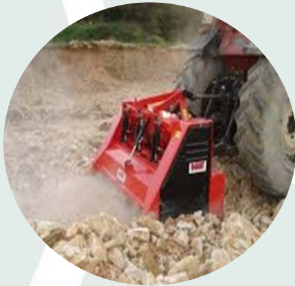
Broyage de cailloux
